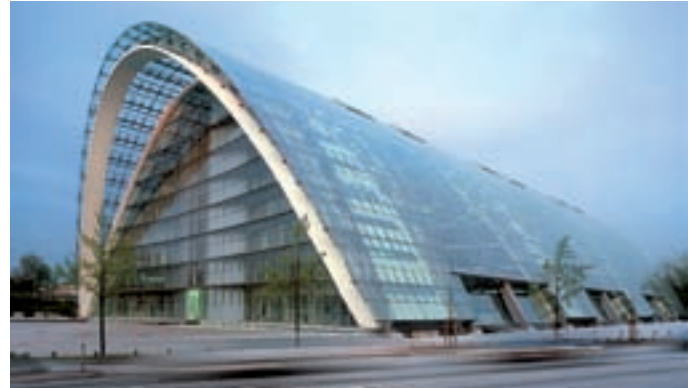
Abb. 1: Berliner Bogen, Nordwestansicht
