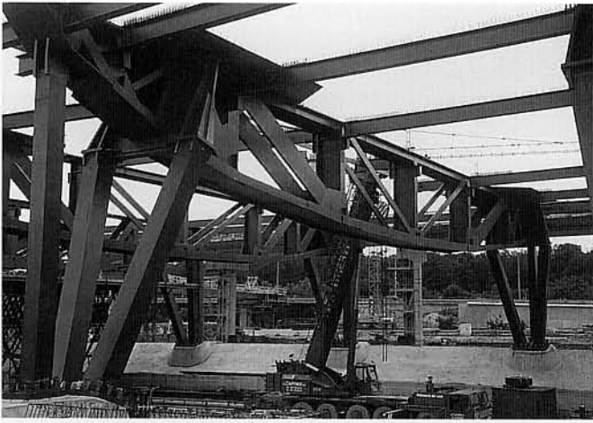
Bild 6. Querrahmen Fig. 6. Cross-frame
