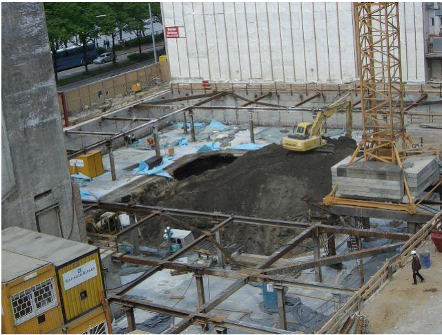
Bild 17: Aushub 2. Ebene Bauteil A
