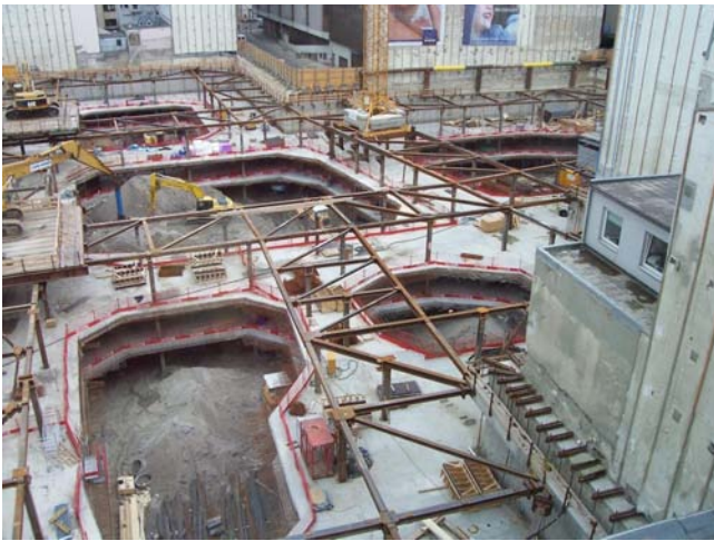
Bild 18: Aushub 3. Ebene Bauteil BC
