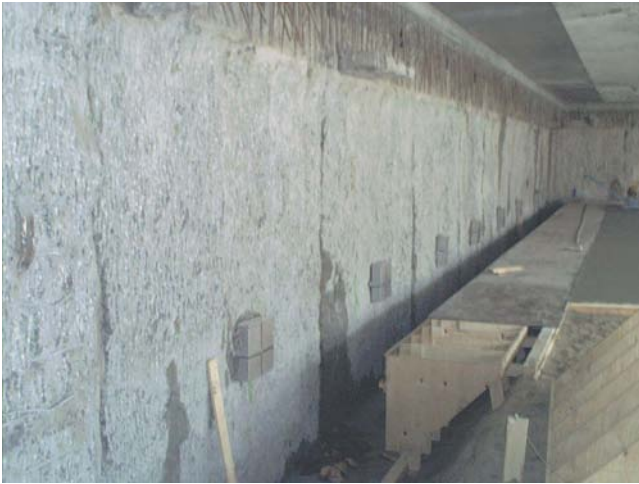
Bild 14: Hammerkopfschalung
