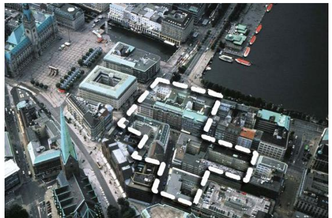
Bild 1: Baufeld vor dem Abriss
