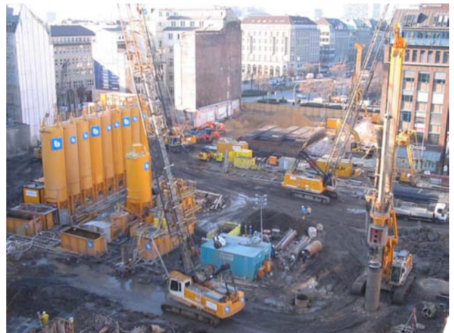
Bild 10: Herstellung Primärstützen
